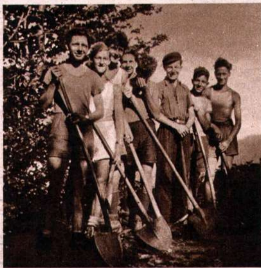
Lavori di correzione a una strada mulattiera.
